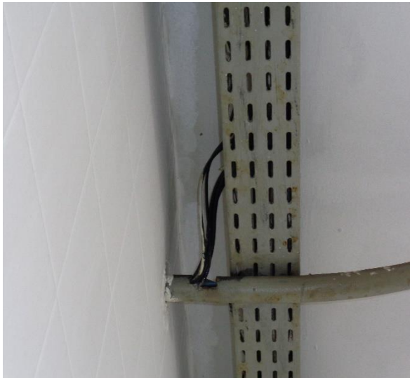
Paneleiro – Fiação Exposta.
