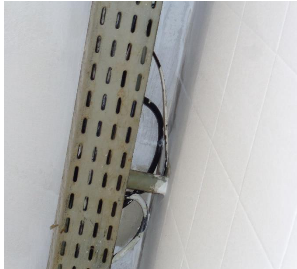
Paneleiro – Fiação Exposta.
